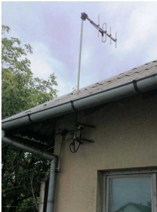
Slika 7. Daljinska signalizacija – komunikacija radijskom govornom vezom
