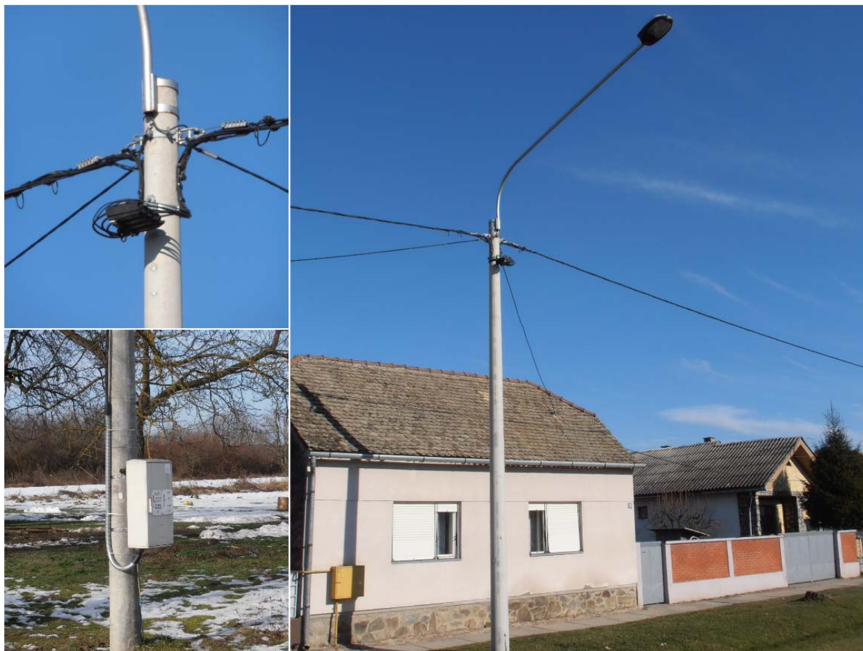
Slika 3. Primjer ugradnje mrežno razdjelnih ormarića
