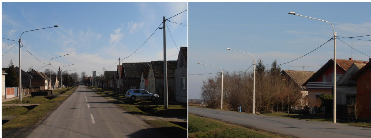
Slika 2. Primjer NN mreža izolirana na bet.stupovima u naselju Marijanci
