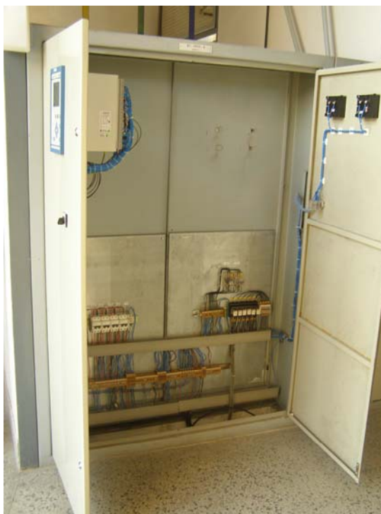
Slika 11. Izgled vrata poslužnih ormara polja nakon rekonstrukcije 35 kV ćelije - iznutra
