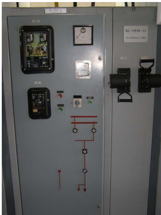
Slika 4. Postojeća elektromehanička zaštita
