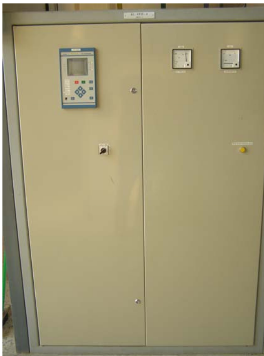
Slika 10. Izgled vrata poslužnih ormara polja nakon rekonstrukcije 35 kV ćelije – izvana
