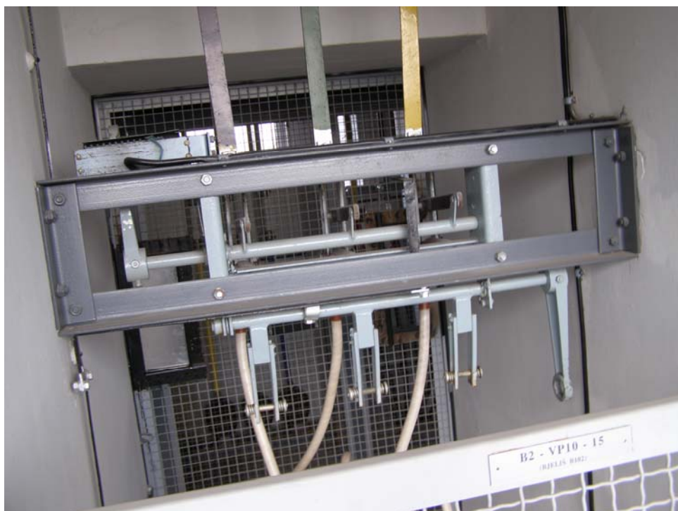
Slika 3. Noževi za uzemljenje
