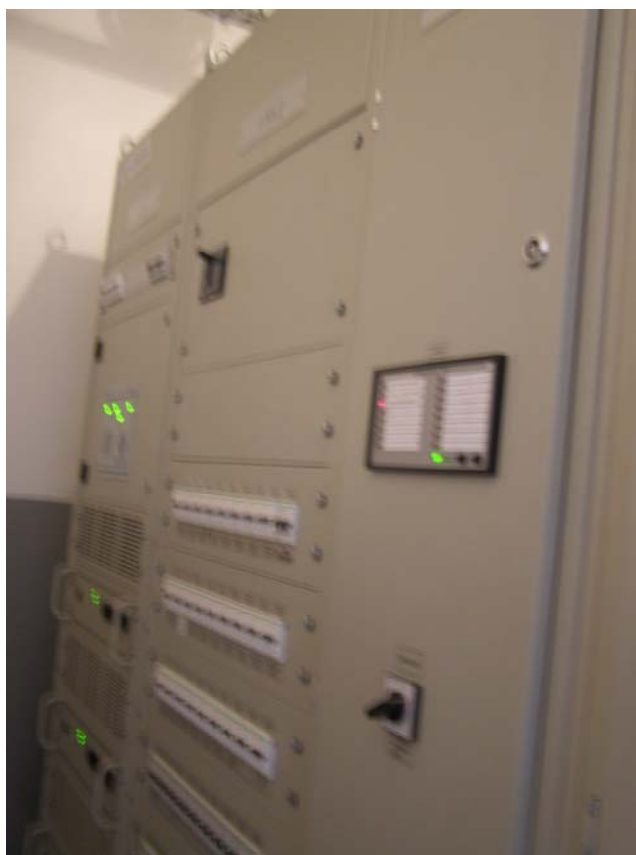
Slika 8. Novi sustav pomoćnog razvoda
