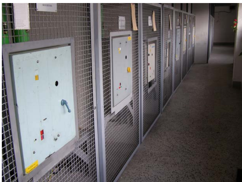
Slika 1. Postojeći malouljni prekidači
