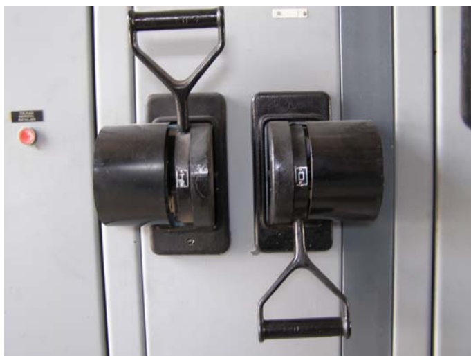
Slika 2. Stremenski pogoni starije izvedbe
