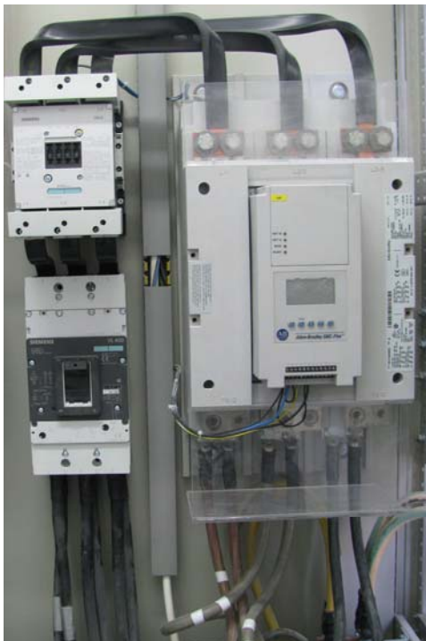
Slika 5. Konfiguracija instalacije Allen-Bradley modulatora i SIEMENS-ovih prekidača.
