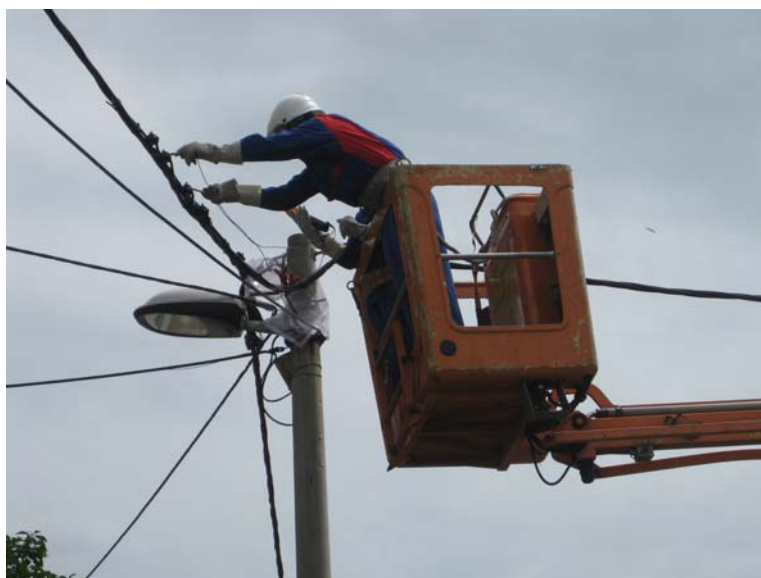
Slika 3: Elektromonter Elektroprimorja pri radu pod naponom
