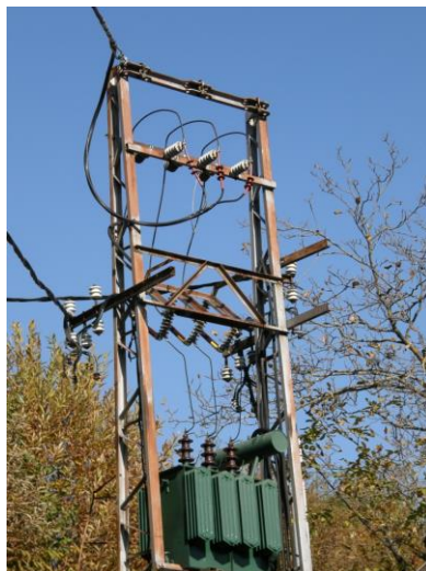
Slika 2. Spajanje kabela EXCEL 12(20)/24 kV 3x10/10 mm 2 na stupnu transformatorsku stanicu [2]
