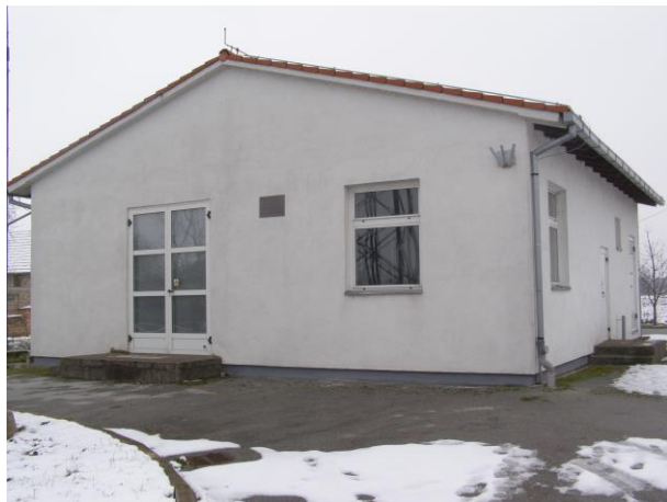
Slika 5. a) TS 35/10(20) kV Trnjani
