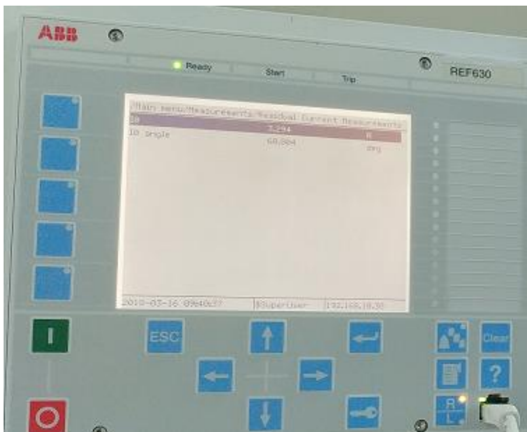
Slika1. Prikaz iznosa struje I_0 promatranog VODNOG POLJA
