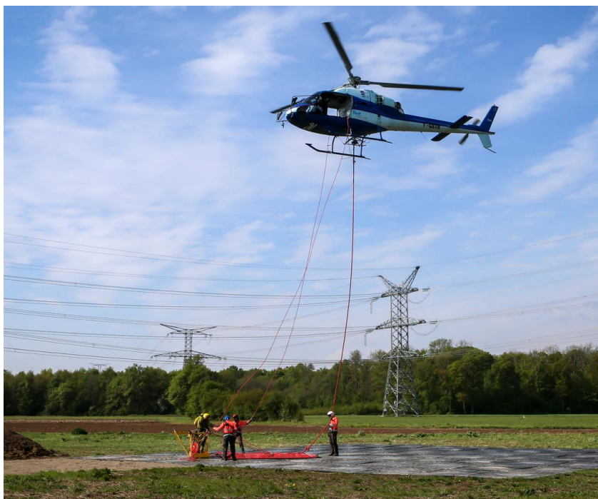
Slika 13. Priprema helikopterskog prijevoza montera RTE-a u ograđenoj platformi na popravak vodiča na DV 225 kV
