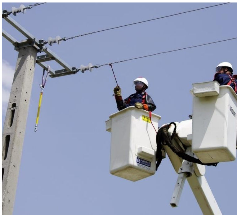
Slika 10. Monteri HEP NOC-a na zamjeni zateznog izolatora na DV 22 kV
