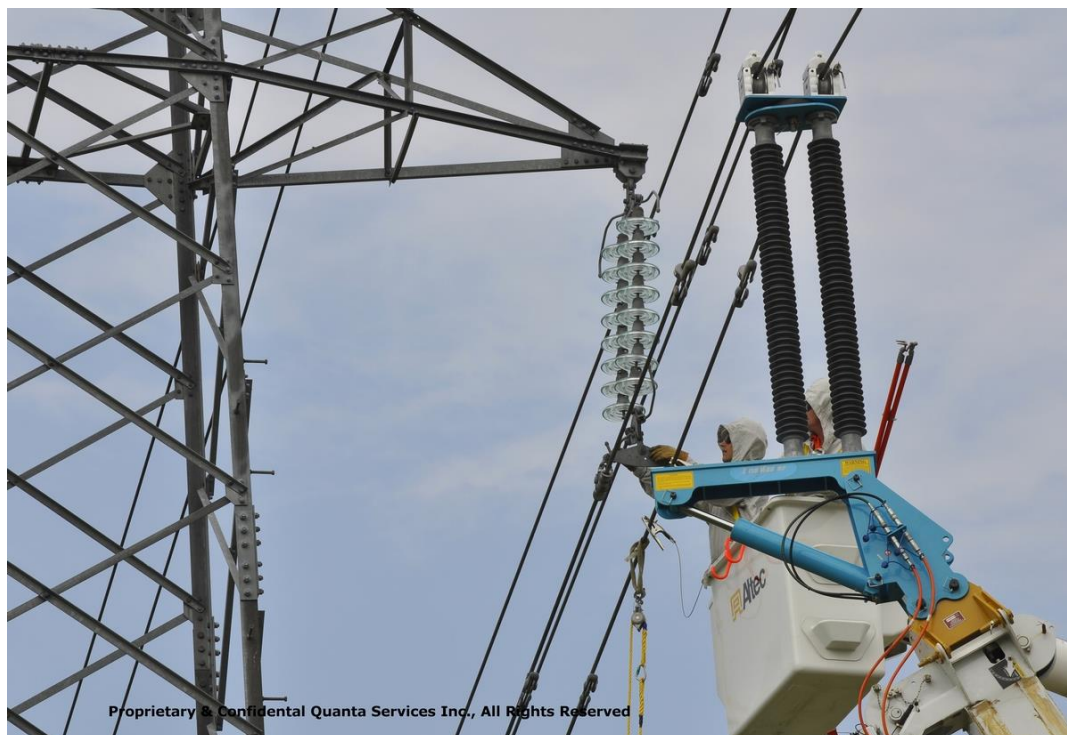
Slika 5. Monteri iz SAD-a na zamjeni 110 kV izolatora pomoću uređaja Quanta
