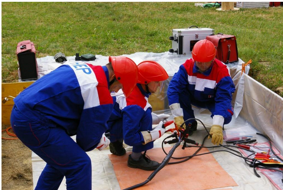
Slika 9. Monteri Elektre Zadar na popravku NN kabela
