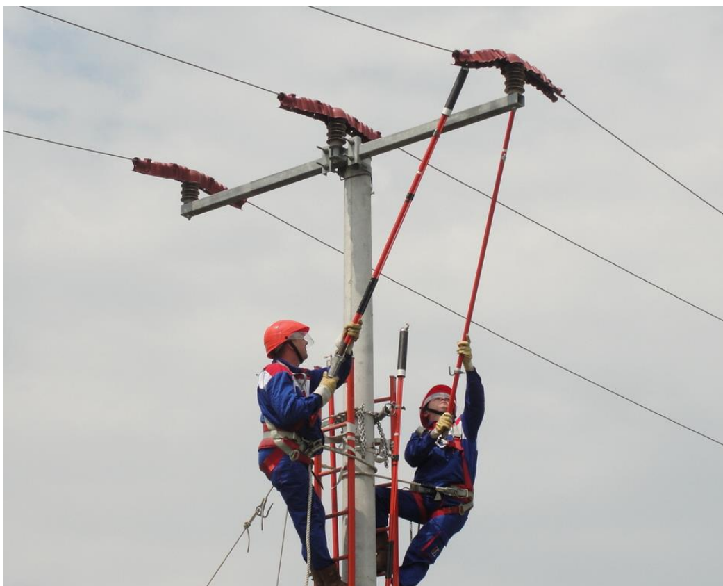
Slika 7. Monteri HEP NOC-a na postavljanju izolacijske zaštite za ptice na 20 kV vodu
