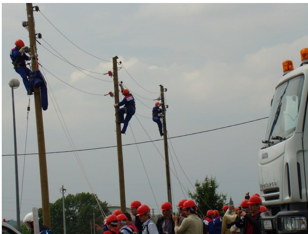
Slika 8. Monteri Elektre Zabok na NN mreži-priprema za zamjenu golih vodiča s SKS-om
