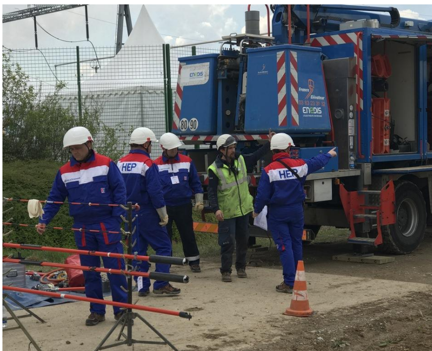
Slika 12. Priprema montera HEP NOC-a za rad na DV 22 kV
