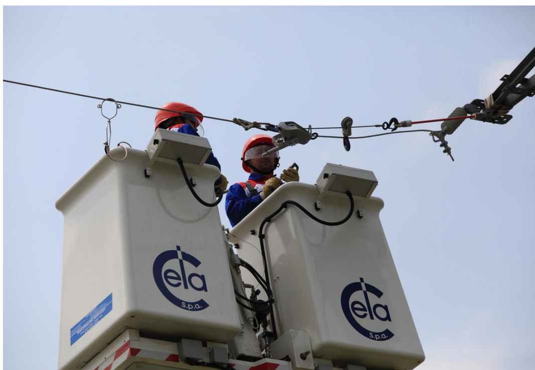
Slika 6. Monteri HEP NOC-a na zamjeni zateznog 20 kV izolatora s platforme
