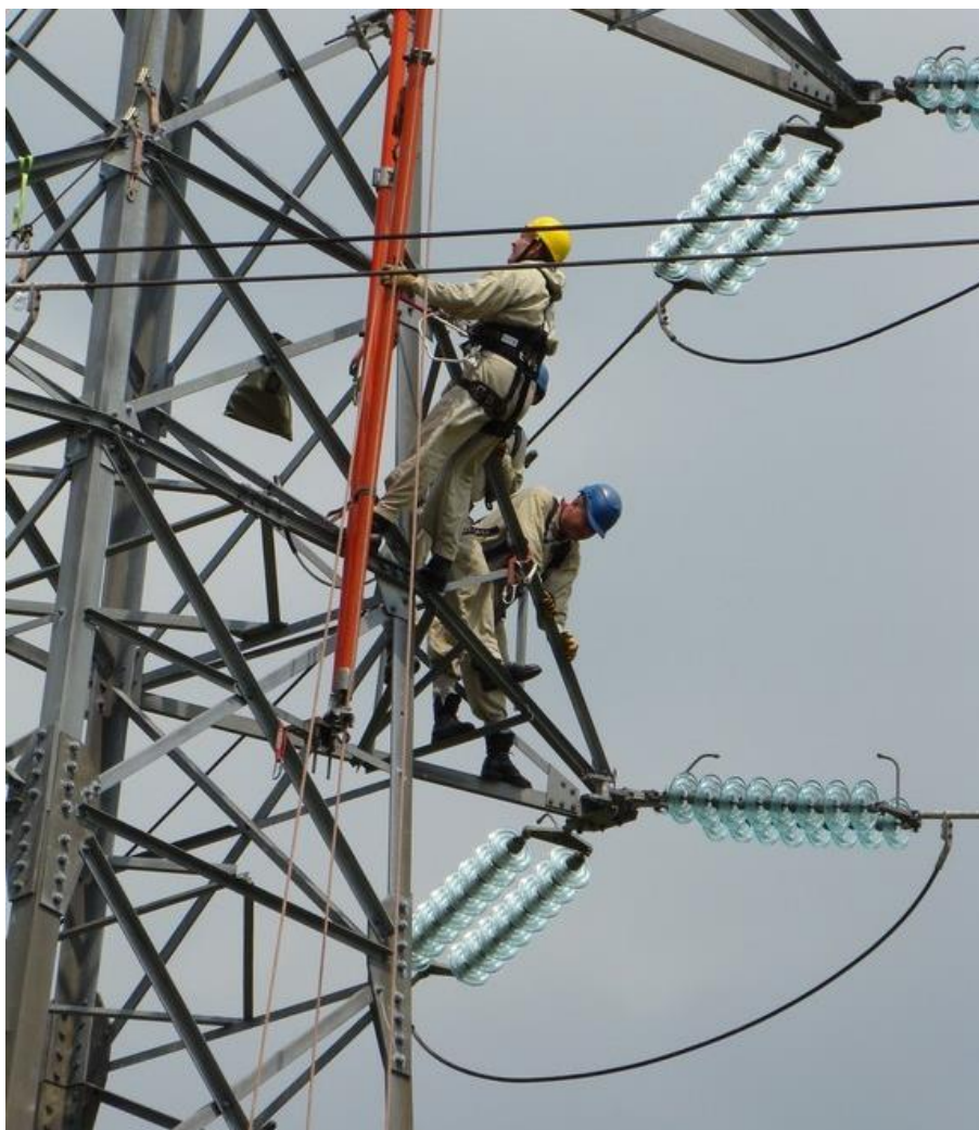
Slika 3. Poljski monter na zamjeni zateznih izolatora na 110 kV vodu
