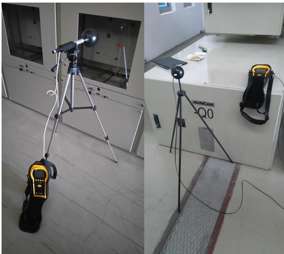
Slika 5: Mjerenja elektromagnetskih polja u TS 110/10 kV Savica
