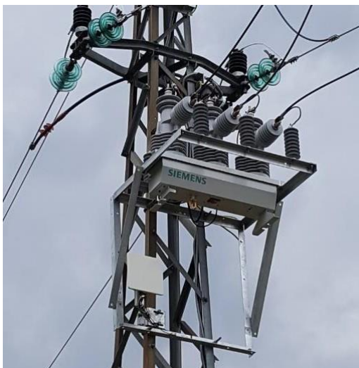
Slika 10. Vakuumski prekidač i upravljački ormar
