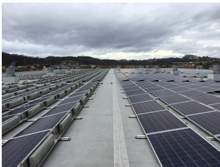
Slika 1. Primjer sunčane elektrane na ravnom krovu
