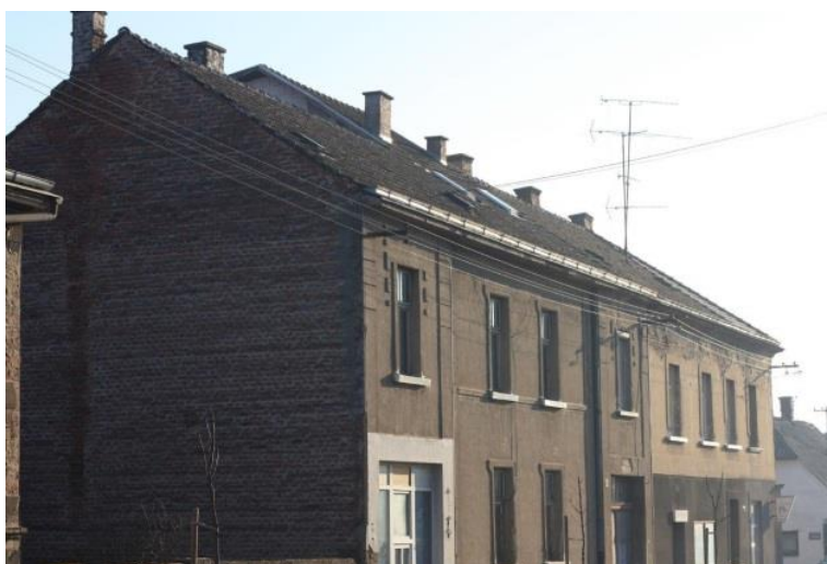
Slika 4. Zidne konzole, izolatori i goli vodiči
