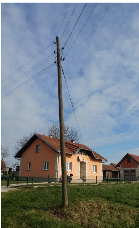
Slika 2. Drveni kutni stup sa sidrom i golim vodičima
