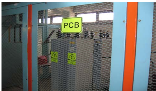
Slika 1. Označavanje kondenzatorskih baterija koje sadrže PCB (TS 110/10 kV Sopot - Zagreb)
